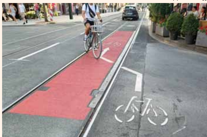
Einmündung Schwerinstraße in die Nordstraße
