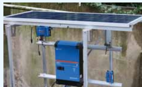
◀ Ich habe ein starres Glas-Folie-Modul verwendet, das mit seiner Fläche von rund 1,48 x 0,68 Meter bestens passt
